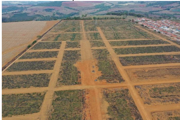
Figura 04: Visão geral da área do empreendimento.
